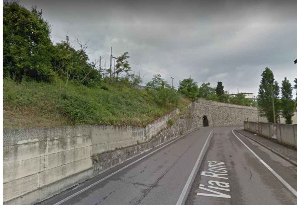
Accesso area cantiere - Quota binario
