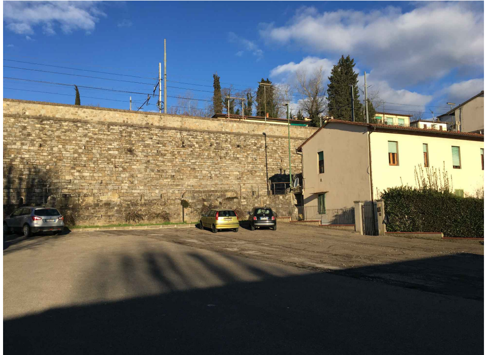
Area cantiere fisso - via Roma
